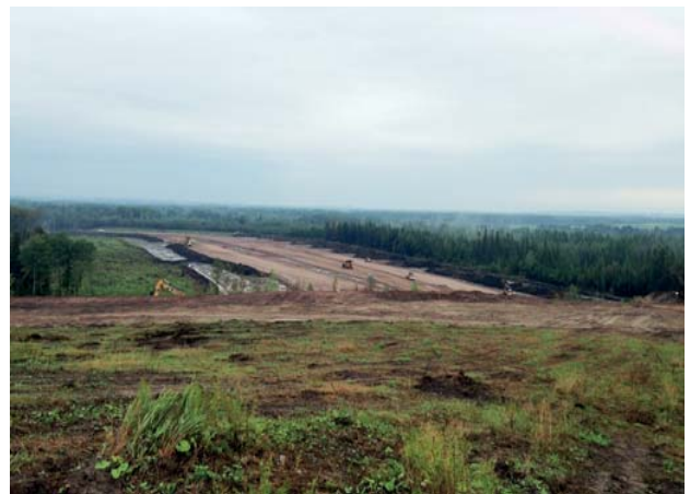
Chantier actuel de la première phase de construction du parc à résidus #3
